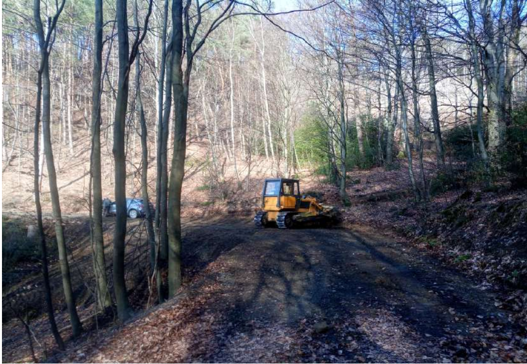
Eine im Wegebau eingesetzte Planiererraupen im Grundsberg, unterhalb der Hängenhardt
