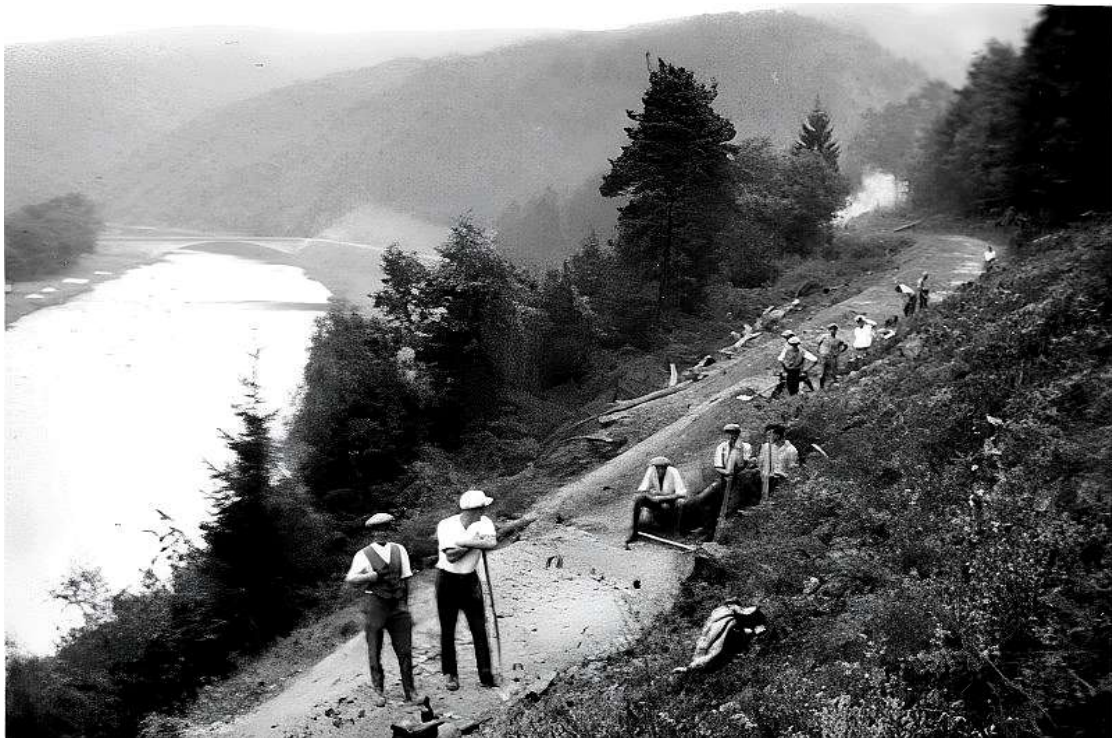
Arbeiter während des Straßenbaus
