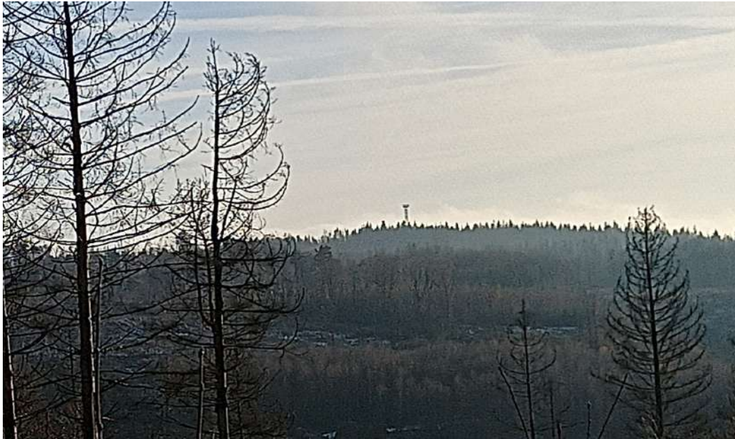
Der fertige Mast im Dezember 2023
