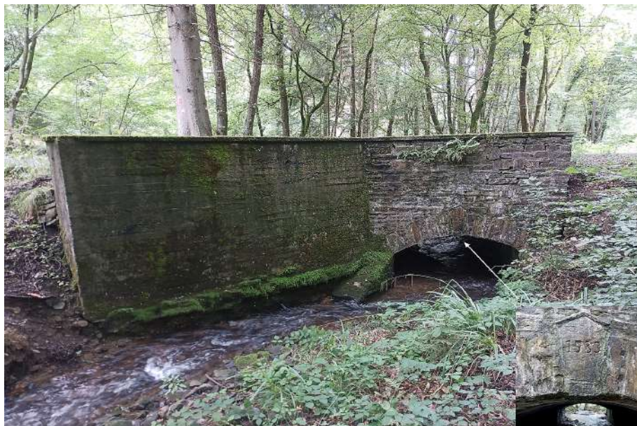
Brücke über den Mühlenbach mit eingeschlagenem Erbauungsjahr
